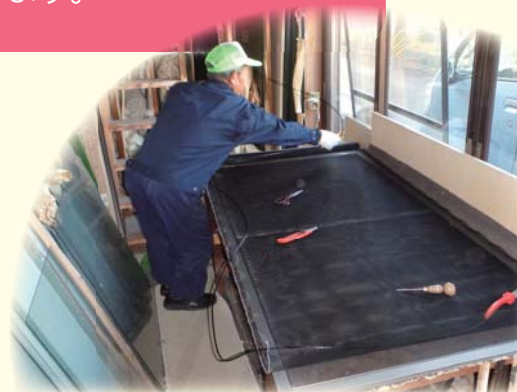
▲ 網戸の張替え作業
