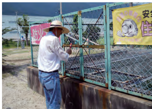
▶ 防火水槽のペンキ塗り直し
